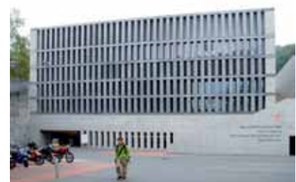
Die beiden neuen Doppelturnhallen (plus mehrgeschossige Zwischenzone mit Kraftraum etc.) sind im Minergiestandard erbaut. Die Anlagen können von den Vereinen genutzt werden. Darüber befindet sich ein Sportplatz, darunter das Parking mit 105 Plätzen.
