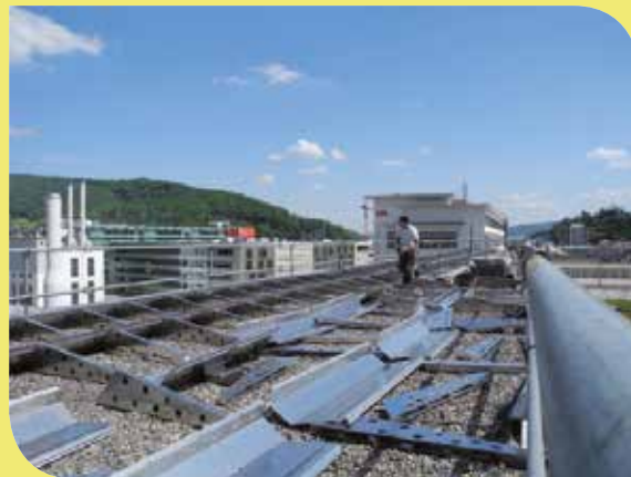
Solaranlage auf dem Schulhaus Bruggerstrasse im Aufbau
