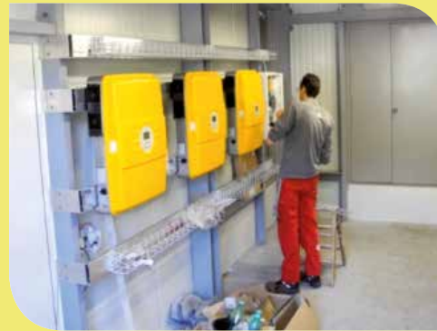
Installation der Wechselrichter, um den Strom ins Netz einzuspeisen
